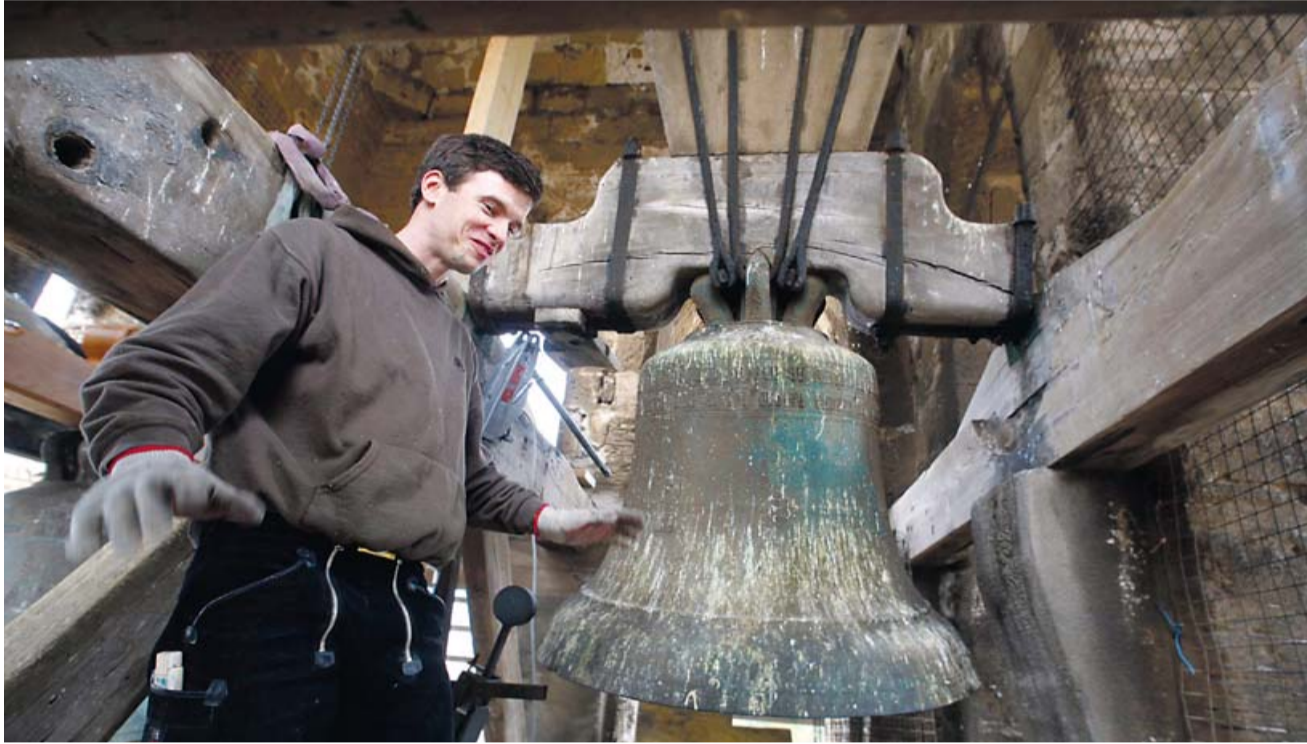
■ Simon Westermann hat Holzjoch und Klöppel erneuert. Auch ein Motor zur Fernsteuerung wurde installiert. FOTO: MIELNIEZUK
